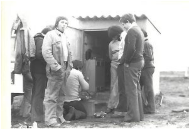
Travail de câblage sur les lieux.(F6FJH Pierre-André à droite)
