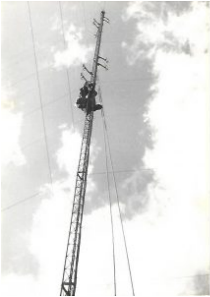
L'installation des premiers aériens, 4 trombones couplés.
