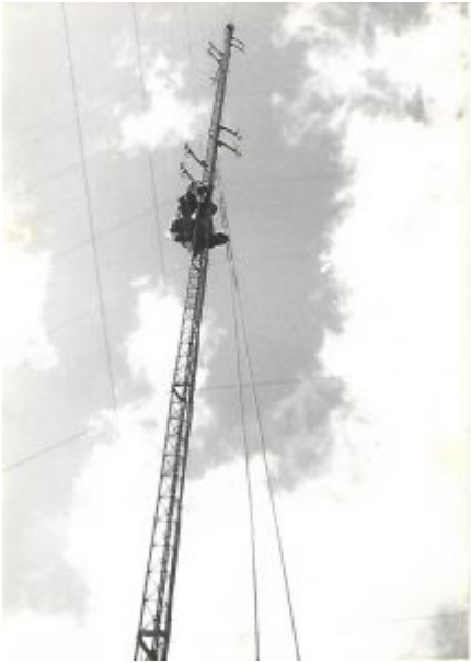
L'installation des premiers aériens, 4 trombones couplés.
